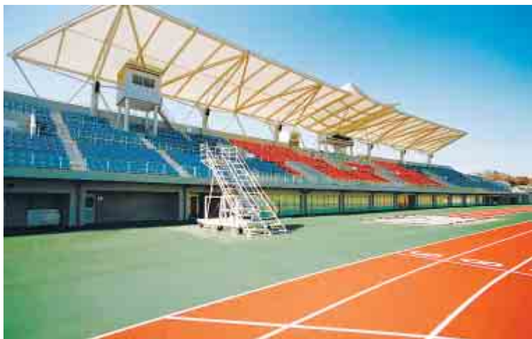
両側からのスタンド全景
