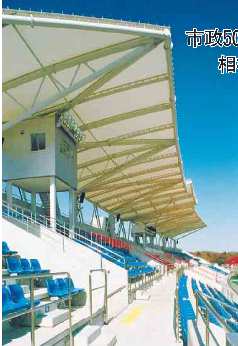
「相模の大風」をイメージした膜構造のスタンド屋根
