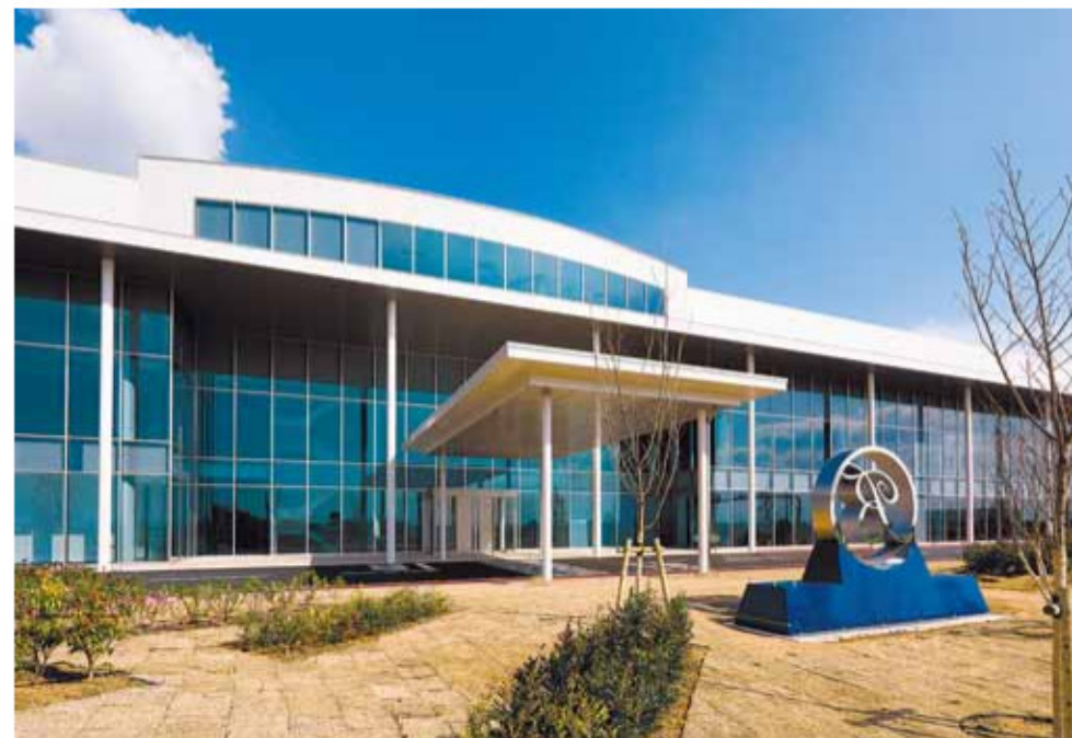
正面エントランスにはモニュメントも置かれている
