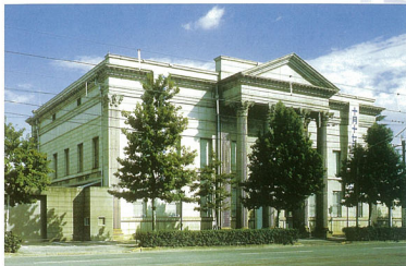
日本銀行岡山支店(現・ルネスホール)
