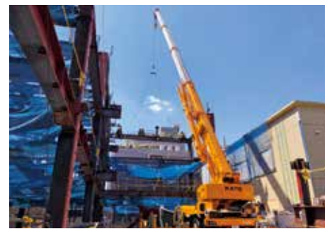
鉄骨建方工事(写真提供:藤木工務店)
