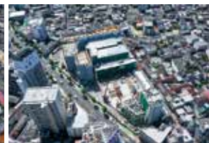
2020年9月29日撮影 1街区A棟鉄骨工事 2街区全棟上部躯体工事
