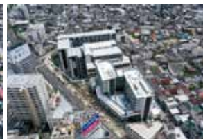
2021年4月30日撮影 外構・周辺空地道路整備工事
