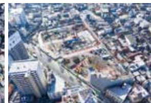
2019年12月14日撮影 1街区既設建物解体2街区地業工事
