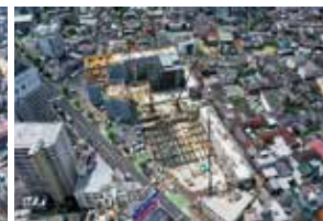
2020年7月31日撮影 1街区A棟基礎・B棟上部躯体工事 2街区ABCF棟上部躯体D棟鉄骨工事
