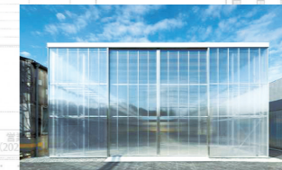
カモ井加工紙mt倉庫新築工事
